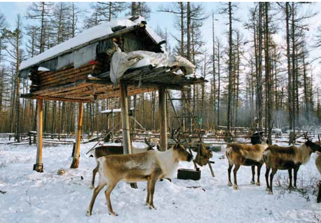
Taigos sandėlys „labazas“: puiki konstrukcija, apsauganti nuo plėšrūnų
