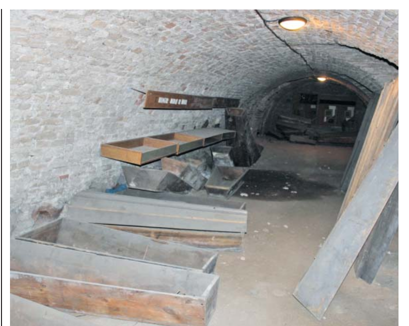
Die Krypta umfasst elf Gewölbekeller, in denen bisher wenig Ordnung herrschte.
